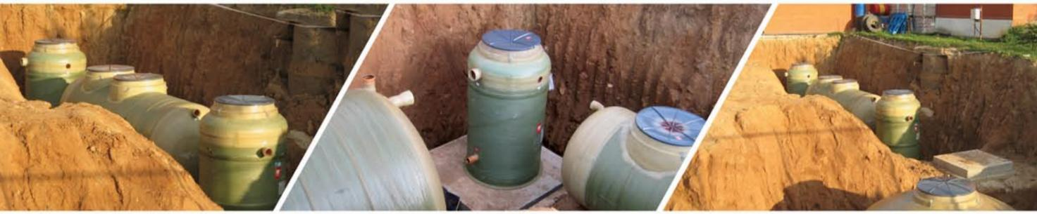
Очистные сооружения производительностью 200 м³/сут и более комплектуются из модулей, составляющих систему NS 400/100, кратно 100 м³/сут.
