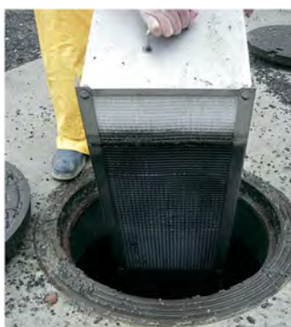
На время обслуживания коалесцентный модуль извлекается из отделителя.
