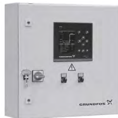
Щит управления насосами
